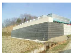
改良盛土壁面状況
