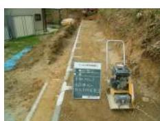
セメント改良盛土
