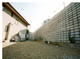
改良盛土壁面状況
