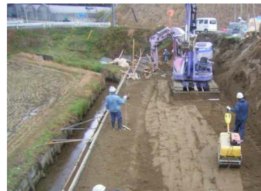
順次改良盛土高が上がる状況
