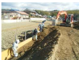
型枠組立、改良盛土状況
