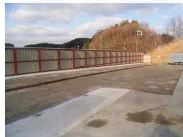
駐車場拡幅工事完了
