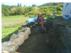
改良盛土状況
