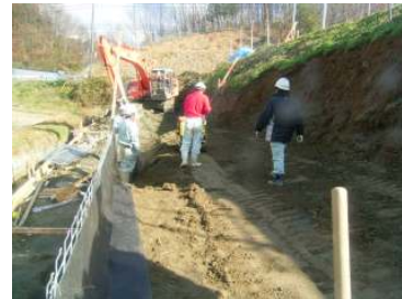
下方部作業状況写真
