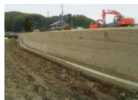
改良盛土壁面状況
