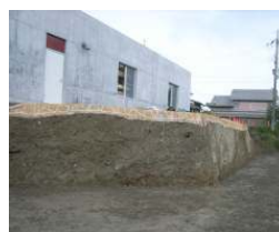
改良盛土壁面状況
