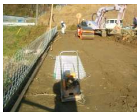
埋込み金網設置、改良盛土状況
