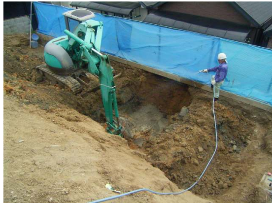
下部改良工状況 (セメント攪拌・混合状況)
