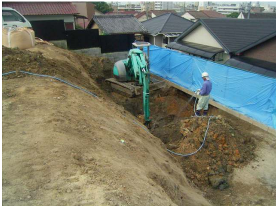
改良後の床付け(杭頭仕上げ)状況
