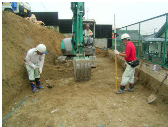
改良後の床付け(杭頭仕上げ)状況
